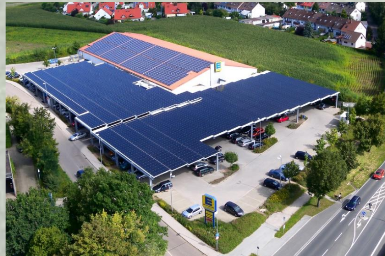
Luftaufnahme der PV-Parkplatzüberdachung, © EDEKA Schwabach
